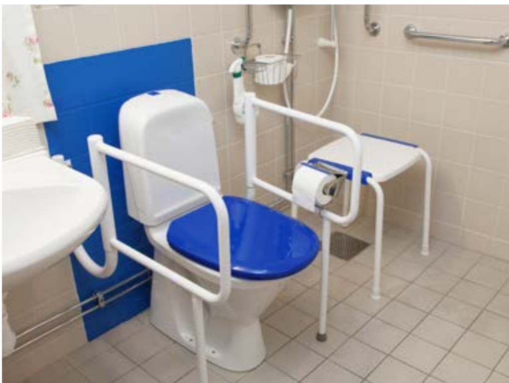
Toaletten ska inredas så att den stödjer tolkning, funktion och integritet. Här syns toaletten bra mot den blå väggen. Foto:Yanan Li/Silviahemmet
